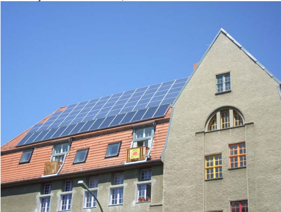
Solaranlage in Berlin
